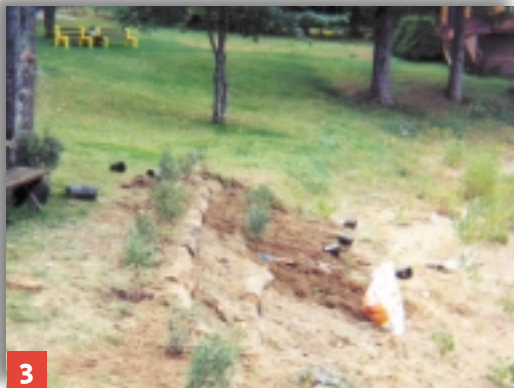
3 Plantation des arbustes de part et d'autre des billots et incorporation de la terre noire et de la terre en place aux plants. La motte des racines des arbustes est enveloppée de jute afin de contenir la terre la première année (selon le site).
