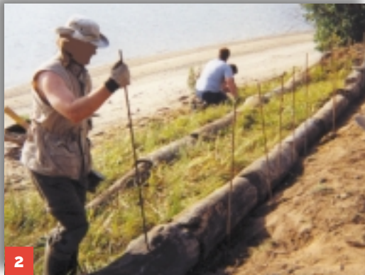
2 Fixation des billots à l'aide des tiges de métal. Les tiges sont insérées dans des trous faits avec une perceuse.
