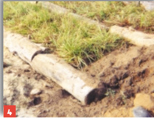
4 Installation et fixation d'un tapis prévégété de toile de coco pour recouvrir les zones dénudées entre les billots. Il est parfois nécessaire d'ajouter de la jute à des endroits délicats entre le billot et le talus.
