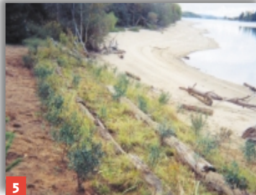
5 Résultat immédiatement après la fin des travaux. Les végétaux vont se renforcer et se densifier à chaque année. Les plantes peuvent être taillées au besoin.
