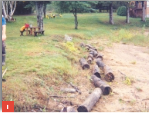
1 Reprofilage de la berge à la pelle afin d'adoucir la pente et disposition en continu des billots de bois.
